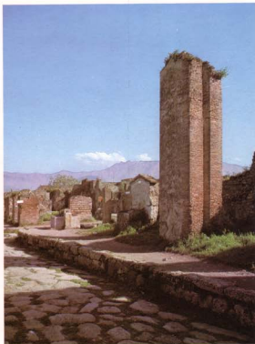
Un château d'eau à l'est de la voie Stabiana (Région VI, insula 14), alimenté par le répartiteur de la porte du Vésuve. Au fond, une fontaine.
