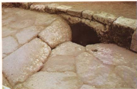
Bouche d'écoulement dans la voie de l'Abondance. Ces bouches sont très rares, puisque Pompéi n'avait pas de véritables égouts.
