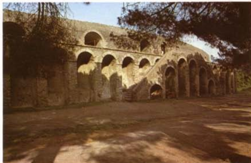
Vue extérieure de l'amphithéâtre (côté ouest). Au centre, les escaliers menant à la summa cavea .
