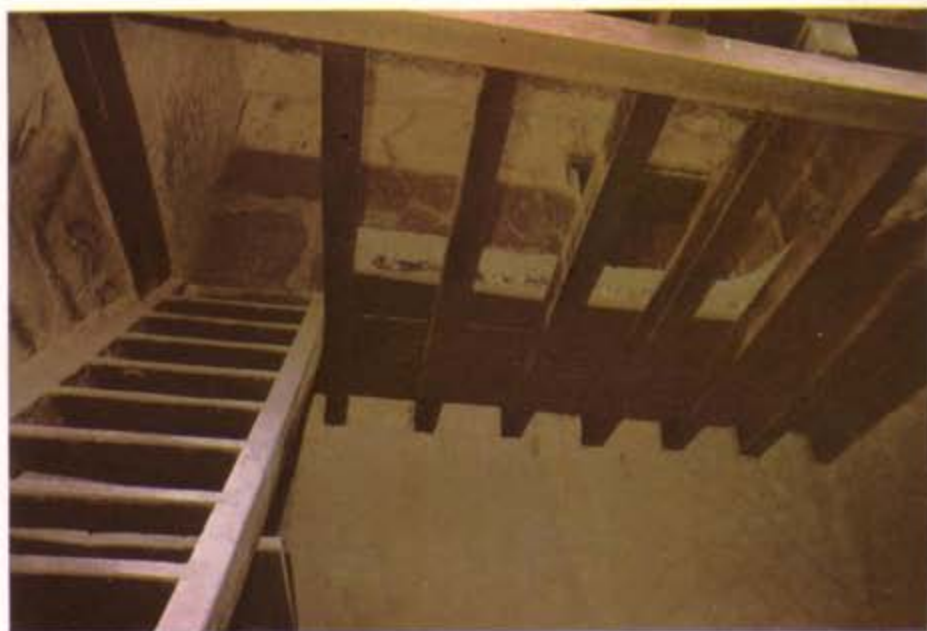
Ci-dessus : Plancher du premier et escalier en bois d'une boutique à Herculaneum. Les chevrons portaient des lattes en bois recouvertes d'une dalle en briques et mortier mélangés.
