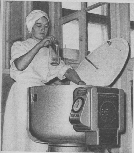
Чтобы вырастить вирус, необходимый для приготовления вакцины, следует не только создать сложную питательную среду из живых клеток, но и тщательно очистить ее с помощью центрифуги
