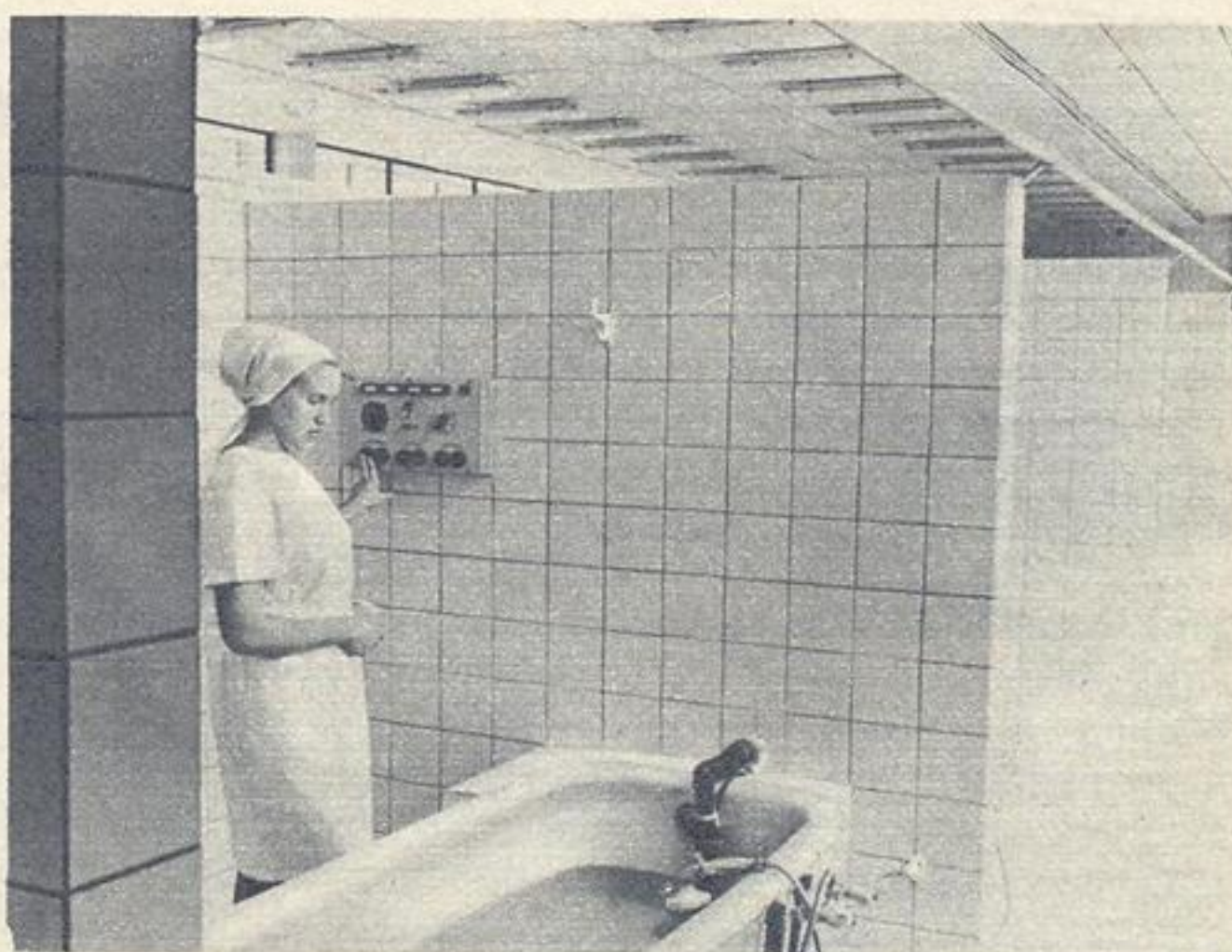
Заполнение ванны производится автоматически, вода поступает заданной температуры и концентрации радона.
