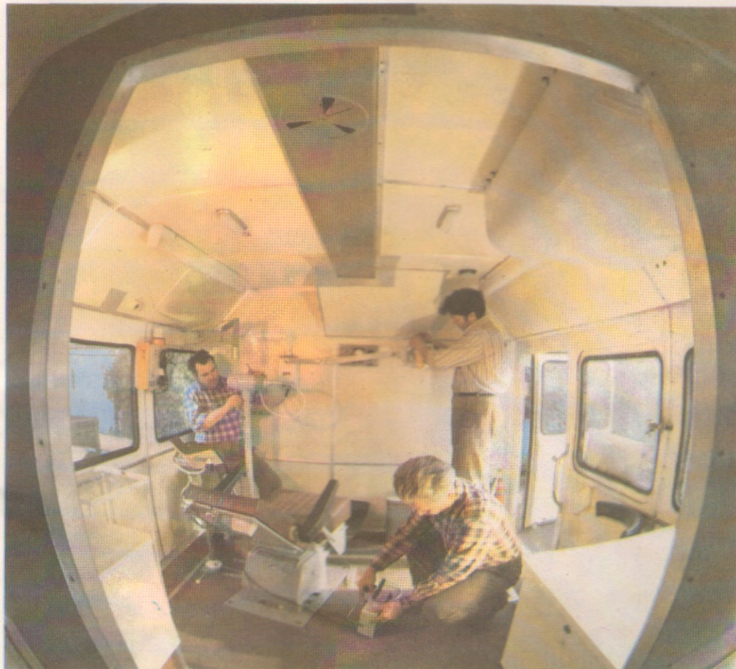
Монтаж оборудования стоматологического ортопедического передвижного кабинета.
