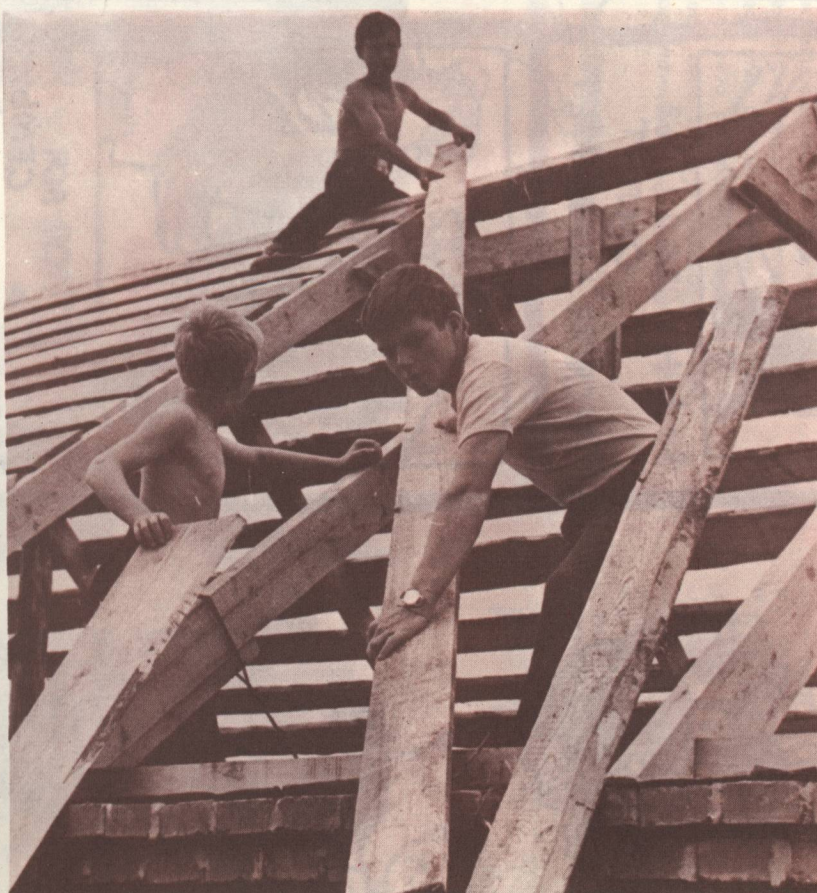
На строительстве колхозного гаража
