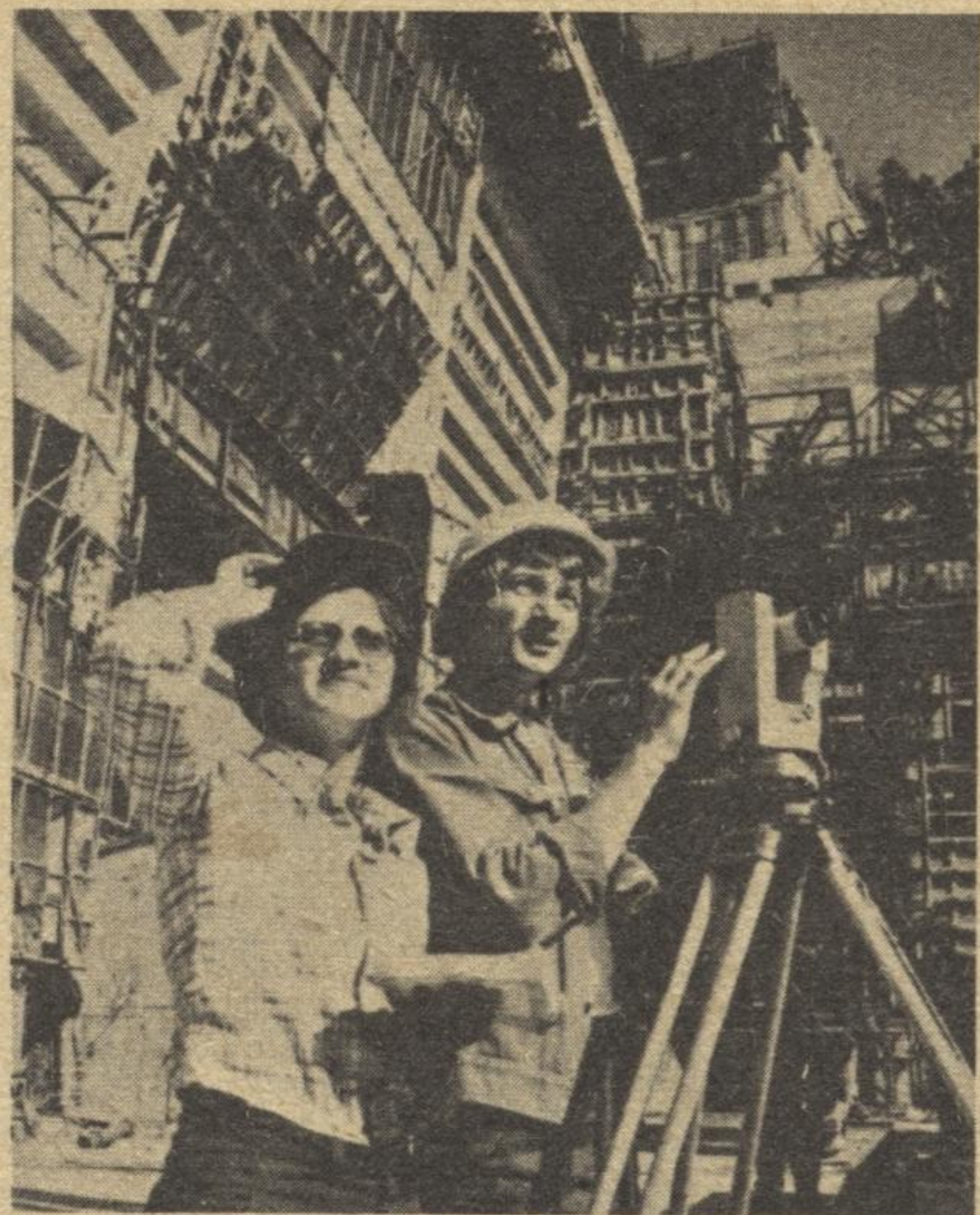
Ни одна стройка не может обойтись без геодезиста. А такая огромная — тем более. Здесь нужна ювелирная точность, и за этим строго следят люди с теодолитами и мензулами. Они скрупулезно проверяют все „вертикали“ и „горизонталы“ плотины и всех сооружений. На снимке: старший инженер-геодезист С. В. Горланов и геодезист Л. С. Лонтеева за работой.
