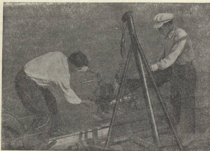
На строительстве Куйбышевского гидроузла. Гидрологи измеряют скорость течения.
