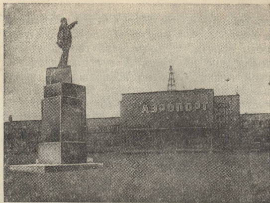
Это — здание аэровокзала. Сооружение на крыше — аэромаяк: мощный прожектор и пирамида из неоновых трубок.
