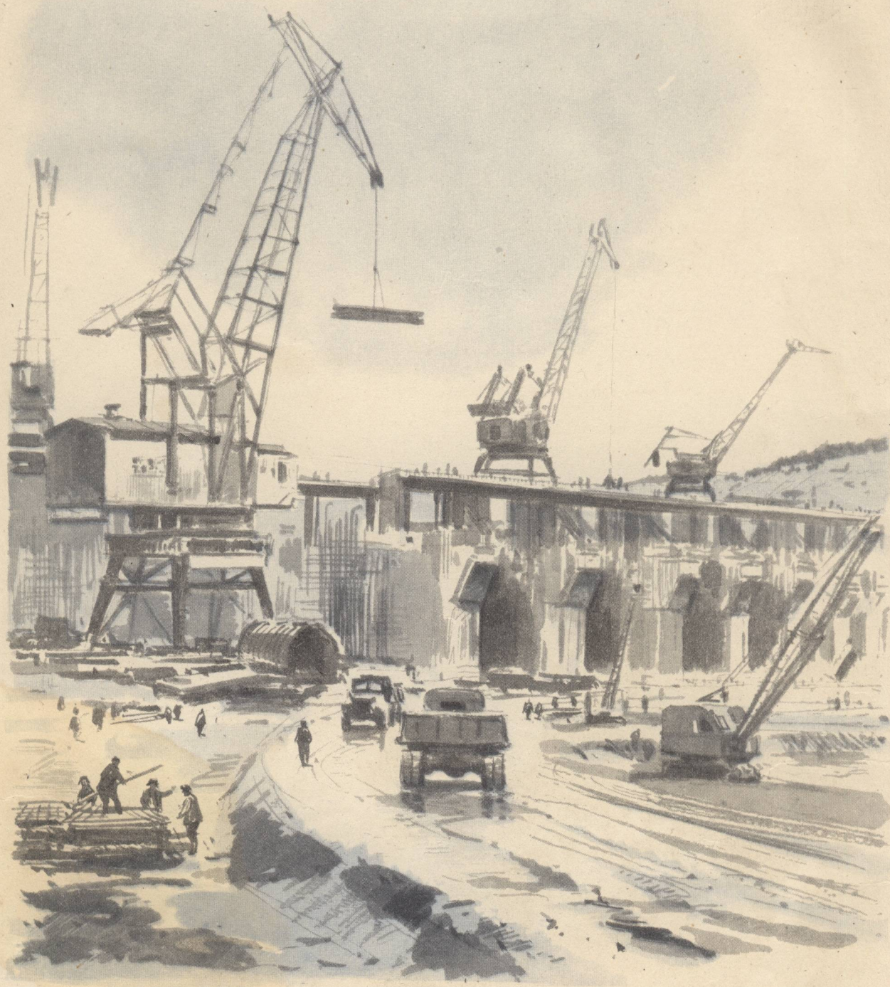
НА СТРОИТЕЛЬСТВЕ ГИДРОЭЛЕКТРОСТАНЦИИ.
