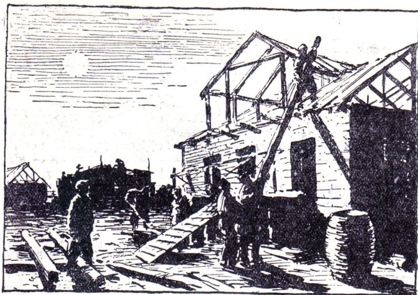
Возле одного строящегося дома работали люди.
