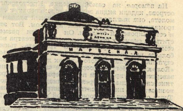
Станция метро «Нарвская».
