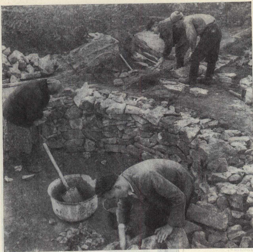
Ребята заканчивают кладку фундамента. Башня будет поставлена тут на века.
