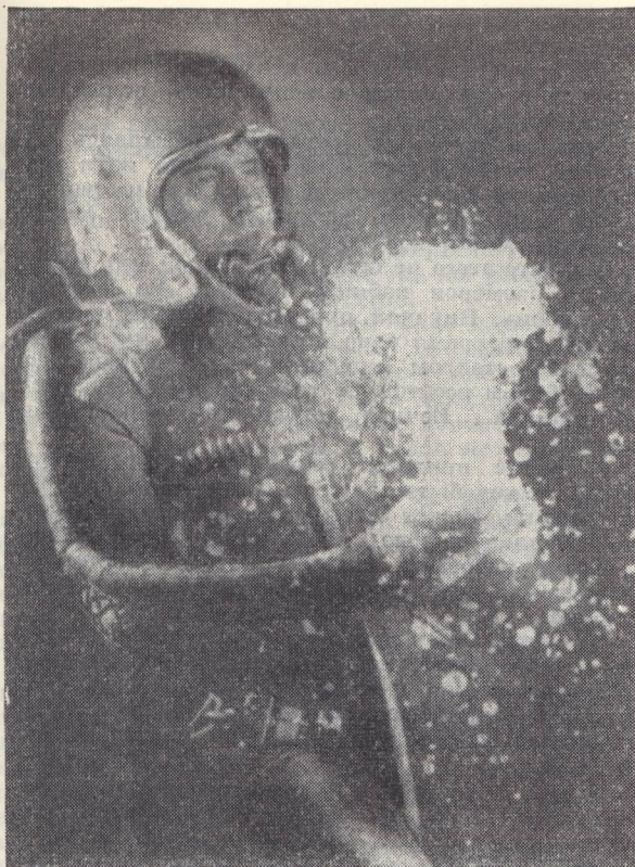
Опыт в барокамере. Атмосферное давление резко понизили, и вода в стакане закипела. А человек чувствует себя прекрасно. Его защищает скафандр.
