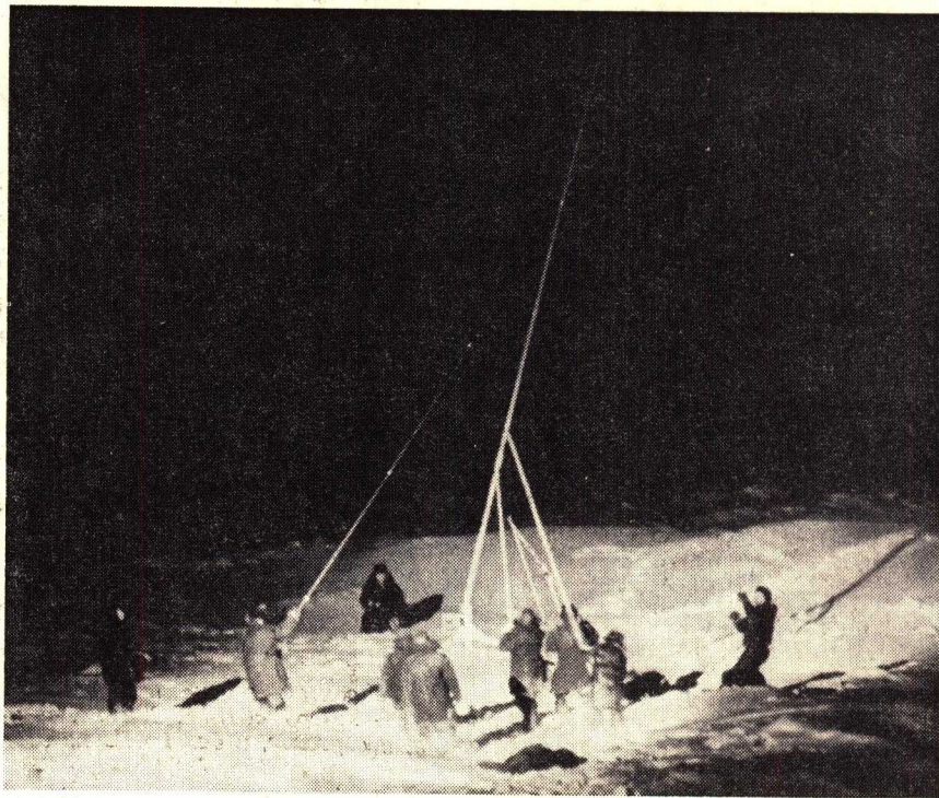
В темноте полярной ночи, прорезаемой лучом прожектора, идет напряженная работа: на дрейфующей льдине оборудуется автоматическая метеостанция. Люди улетят, а радиовеха начнет свой дрейф в океане.
