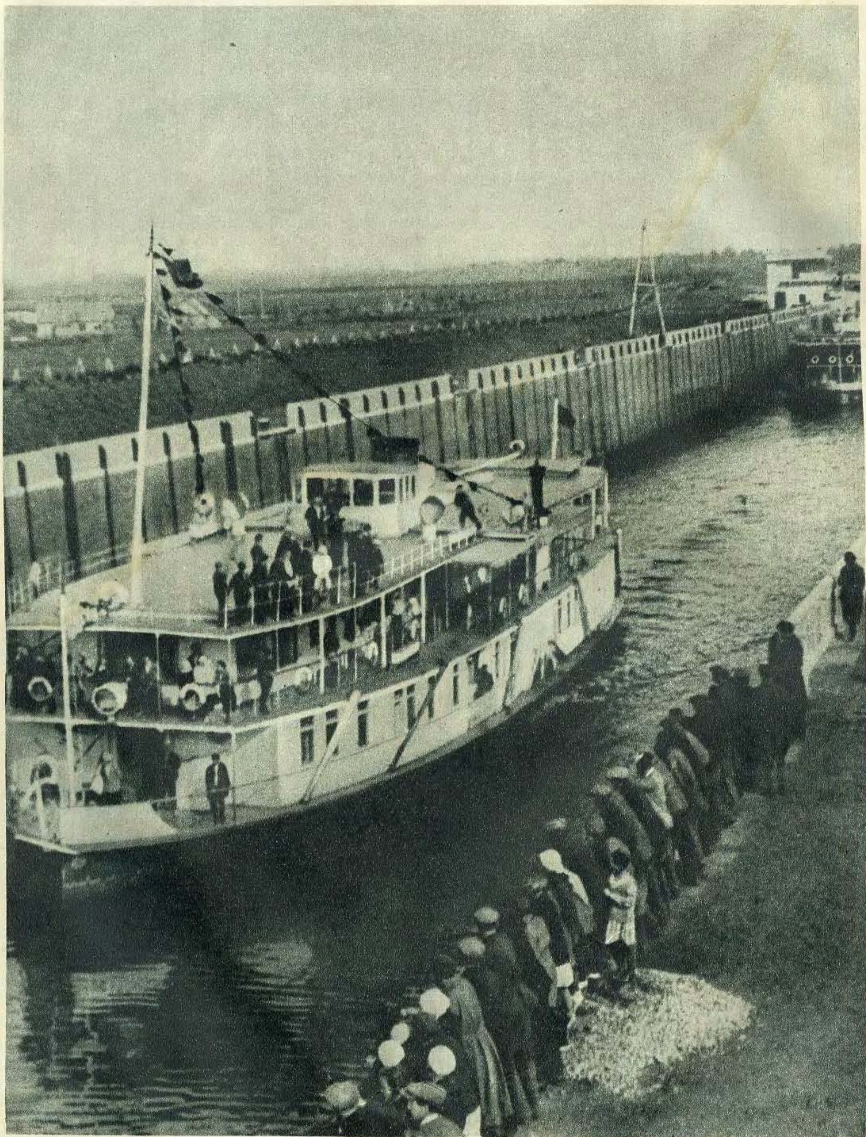
Пароходы, идущие по каналу Москва — Волга, будут переходить с одной водной ступени на другую. Это осуществляется с помощью шлюзов. Один из таких шлюзов — Перервинский — вы видите на этом снимке.
