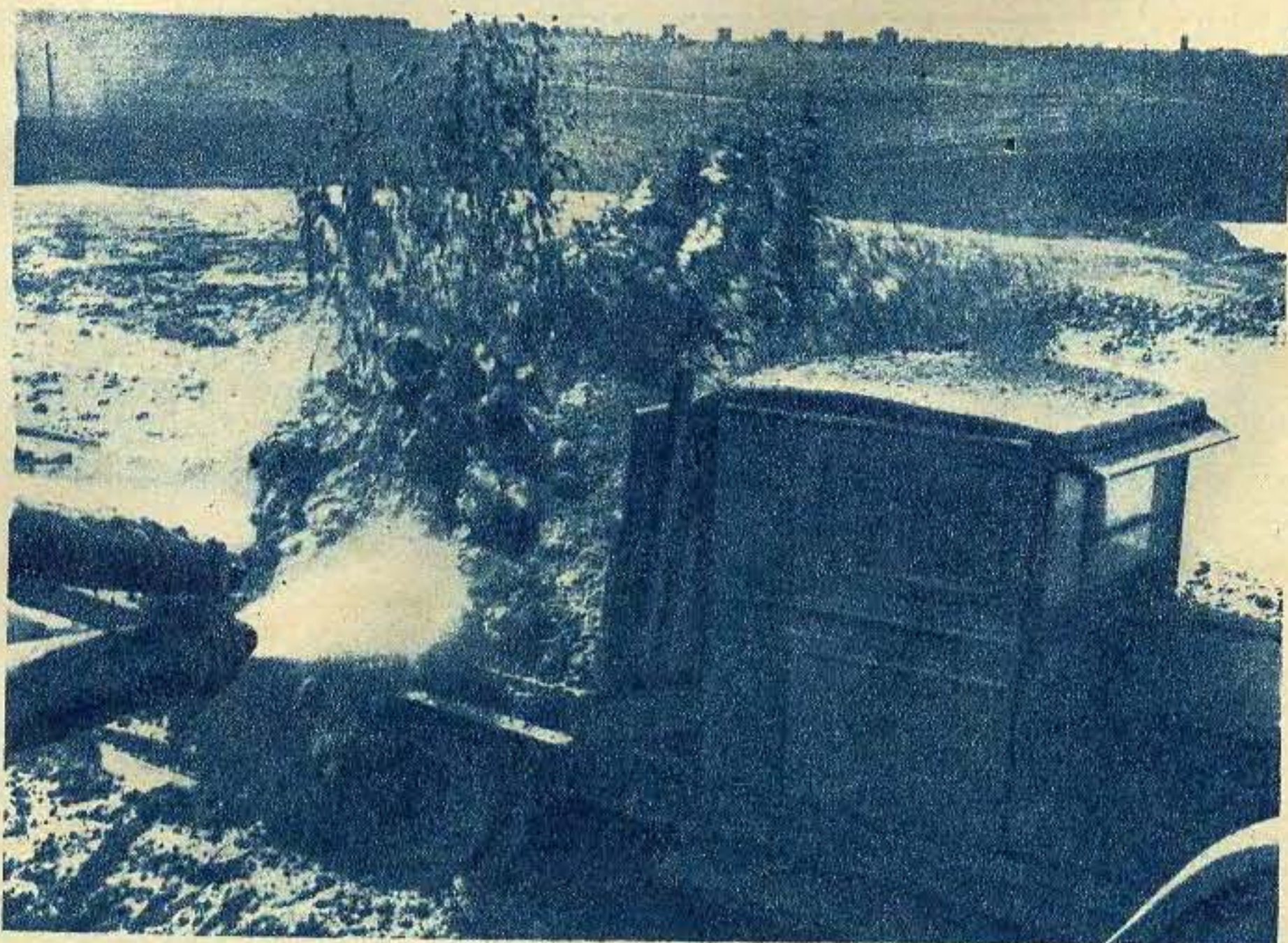
Груженный автомобиль подходит к гидромонитору. Струя воды взмывает грунт. Комья земли с грохотом падают на место отвала.
