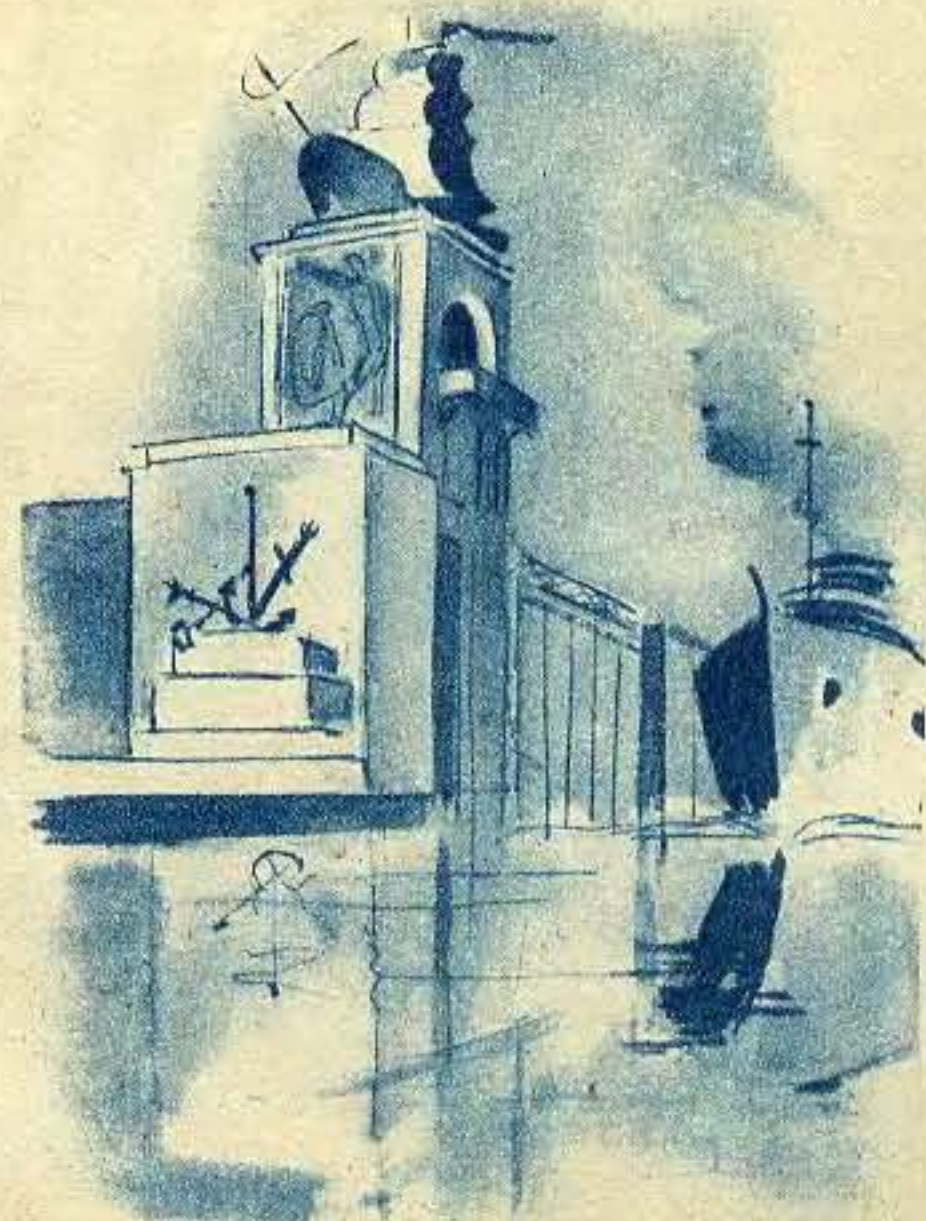
Теплоход проходит мимо башни управления шлюза.
