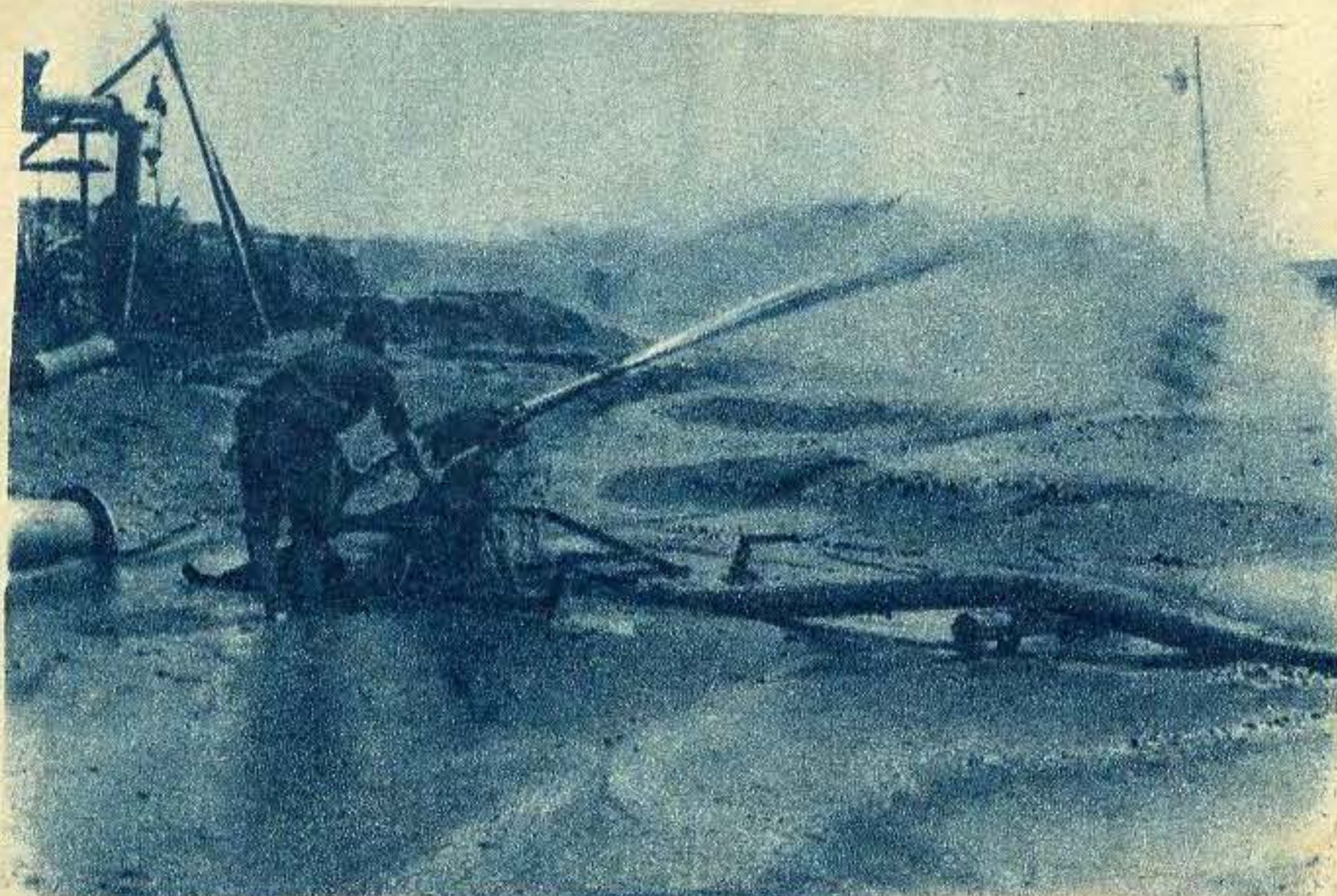
Место работ пустынно. Только подле самого гидромонитора стоит человек. Поворачивая балансир, длинный деревянный рычаг, прикрепленный к стволу гидромонитора, он направляет струю в забой.
