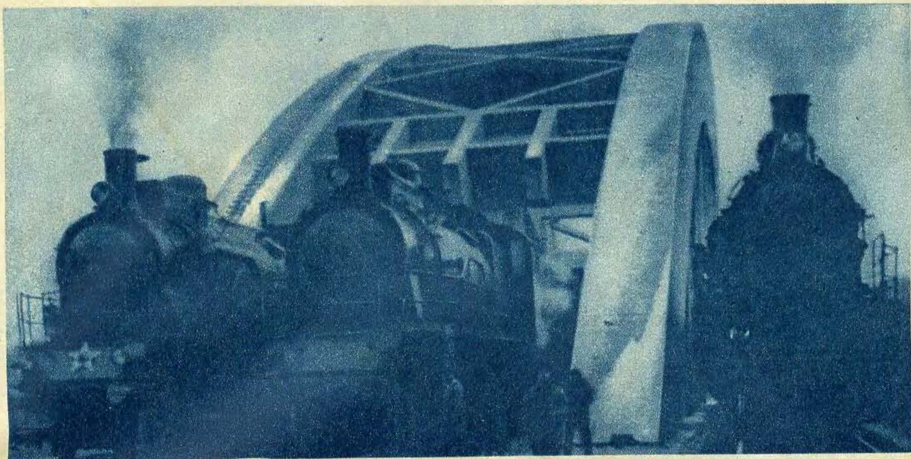
У станции Химки Октябрьской ж. д. проложен над каналом железобетонный арочный мост. Он несет на себе четыре линии ж.-д. путей. Крайние линии размещены вне арок, на специальных свесах, которые похожи на массивные длинные балконы.
