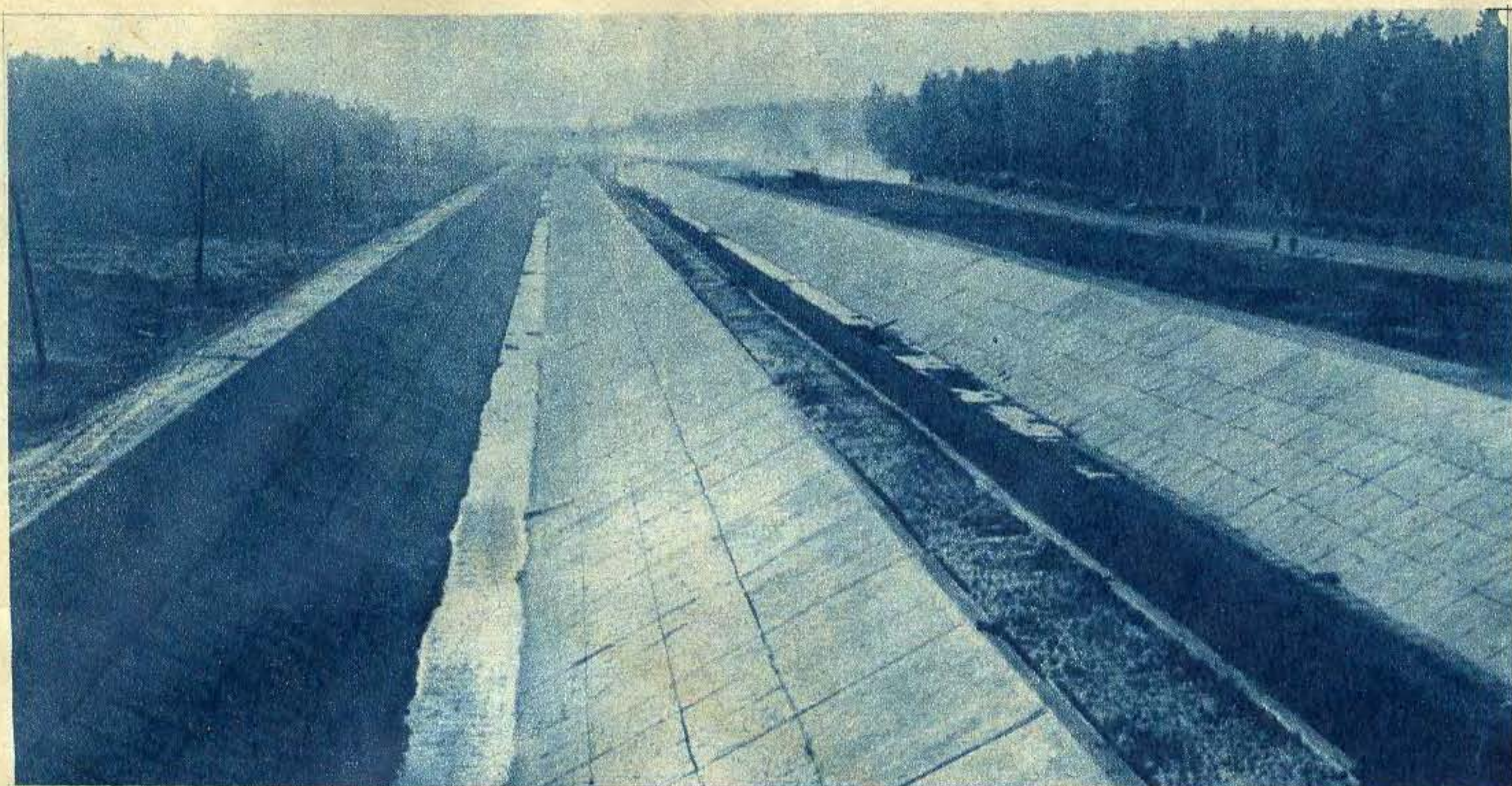
Кроме судоходного канала, построен еще и водопроводный. Он должен дать Москве питьевую воду. Длина его—28 километров. На снимке: готовый участок этого канала.
