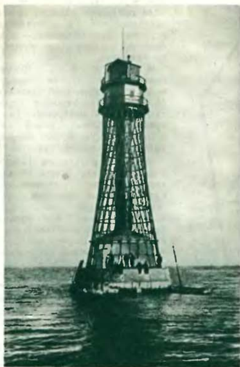
У входа в Херсонский порт стоят две гиперболических башни. Это маяки. Высота одного из них — 27 метров, другого — 85 метров.
