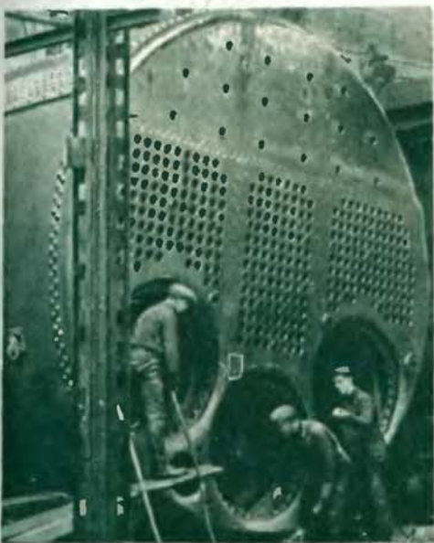
Рабочие за сборкой одного из девяти паровых котлов ледокола.
