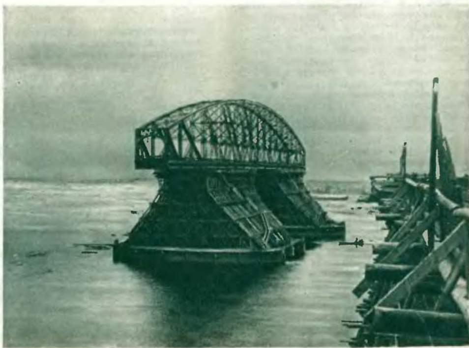
На строительстве одного из крупнейших мостов, сооруженного по проекту Шухова.
