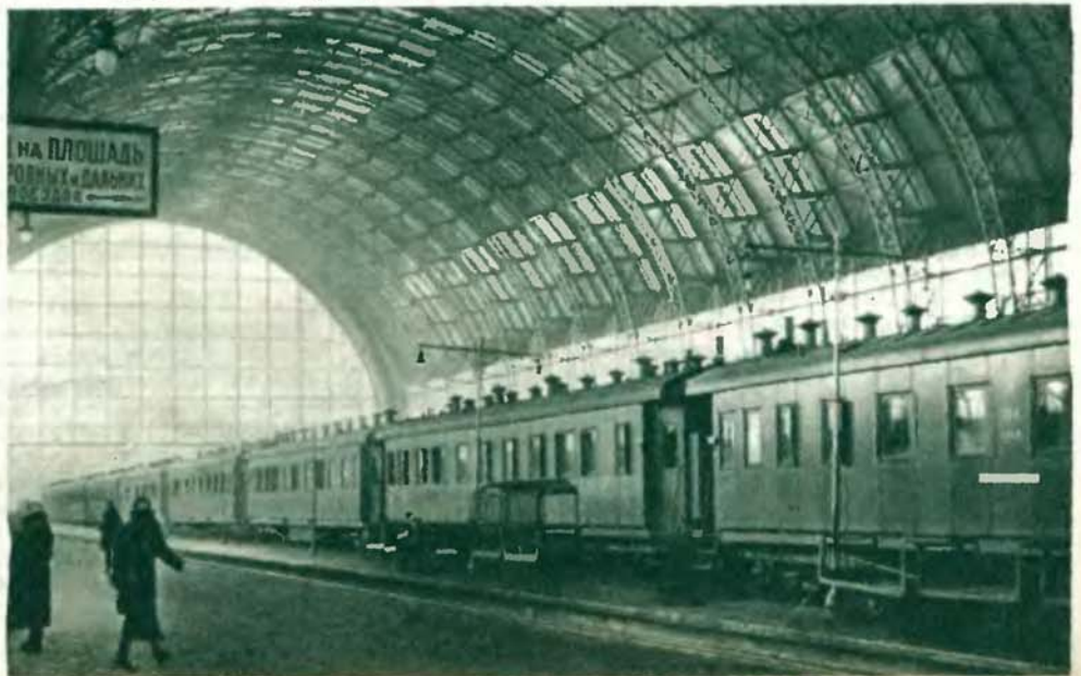
Внутренний вид перекрытия перрона на Киевском вокзале.
