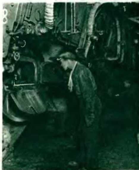
В котельном отделении.
