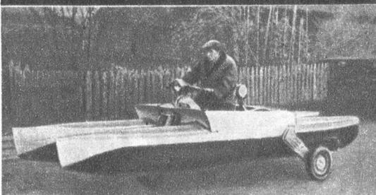
На обложке — автомобиль-амфибия А. ГОРШКОВА. Здесь, на фото, тоже амфибия. Но машина А. Горшкова — «плавающая автомобиль», а это — «ездящая лодка». Авторы конструкции Е. РЫЧКОВ, Л. МОХОВ и В. МАЛИКОВ назвали ее «катамаран-вездеход». Скорость на воде до 12 км/час, на суше — 50 км/час. Длина катамарана — 5 м, водоизмещение — 1500 кг, вес — 160 кг. Двигатель — «ИЖ-49».
