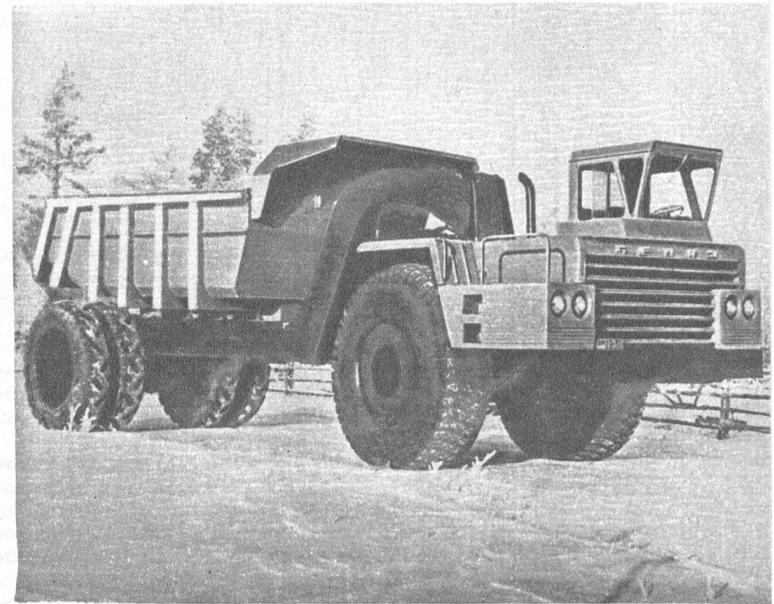
Специальный карьерный автомобиль — одноосный тягач «БЕЛАЗ-530» (с полуприцепом) грузоподъемностью 30 т (СССР).
