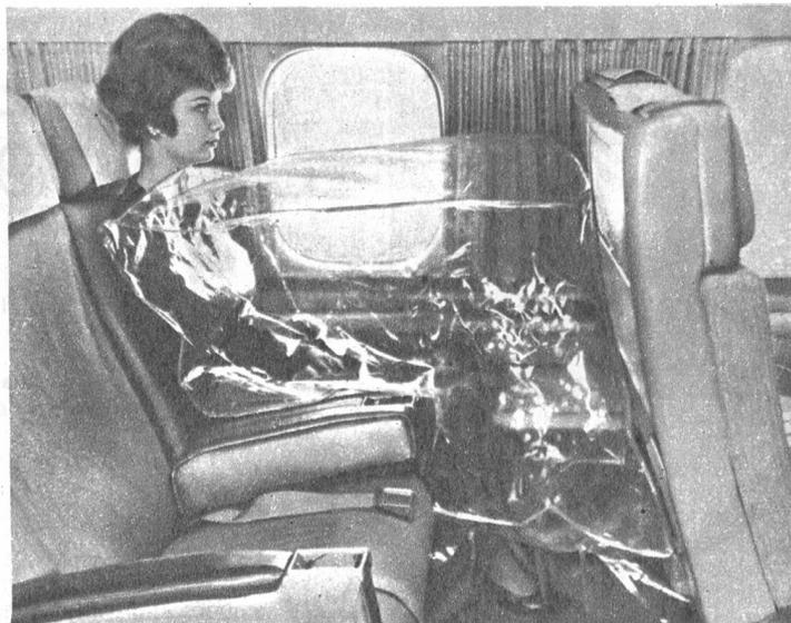
удар о спинку переднего кресла. Для амортизации пространство между пассажиром и спинкой переднего сиденья заполняется автоматически надуваемым пузырем из пластмассовой пленки. Оно то и удерживает пассажира в фиксированном положении. Предполагается, что аналогичную систему можно применять для безопасности космонавтов при резких маневрах космических кораблей (США).
