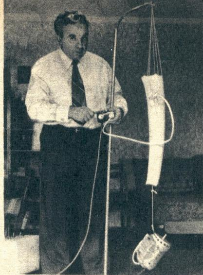
маться, увлекая за собой подвешенный на тросе груз. При этом высота подъема груза вдвое превышает длину хода самой оболочки. Подъемник обладает широкими эксплуатационными возможностями. Он довольно легкий, а потому транспортабелен, его просто смонтировать прямо на строительной площадке.
