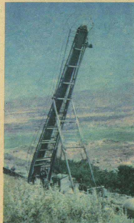
Установка для бурения наклонно направленных скважин.
