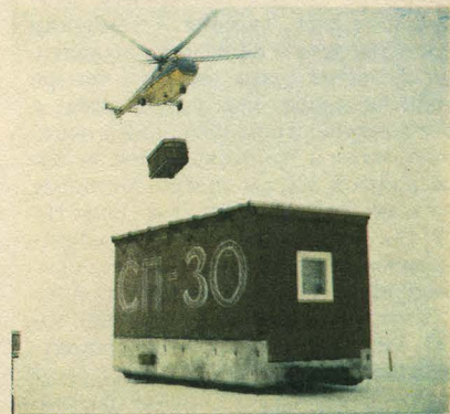
Идет монтаж «квартир» поселка на «Острове Витуса Беринга».
