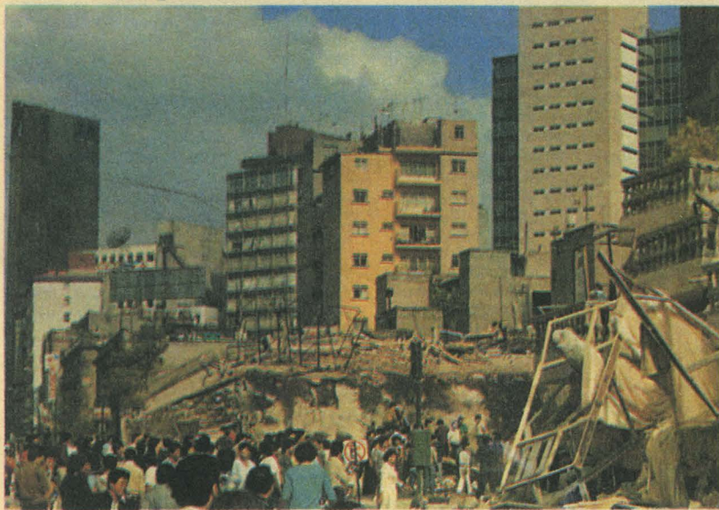
Мехико после землетрясения 1985 года.
