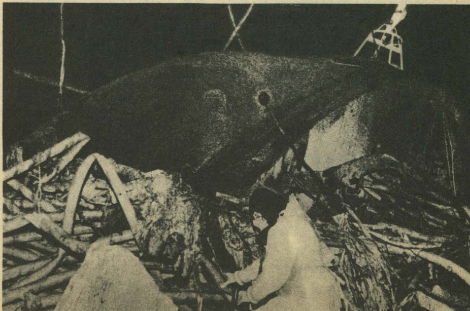
В реакторный зал разрушенного блока удалось проникнуть человеку. И не просто проникнуть, а взобраться на самое опасное место — на «Елену». Так называют здесь металлоконструкцию крышки реактора — схемы «Е», которая при взрыве встала почти вертикально, вырвав при этом из аппарата сотни технологических труб.
