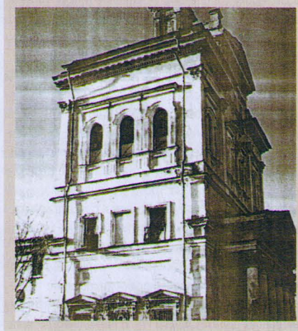
3. Башня городского водопровода в Кронштадте
