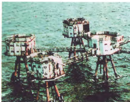
Фотография форта с воздуха. Видны переходные мостики между башнями
