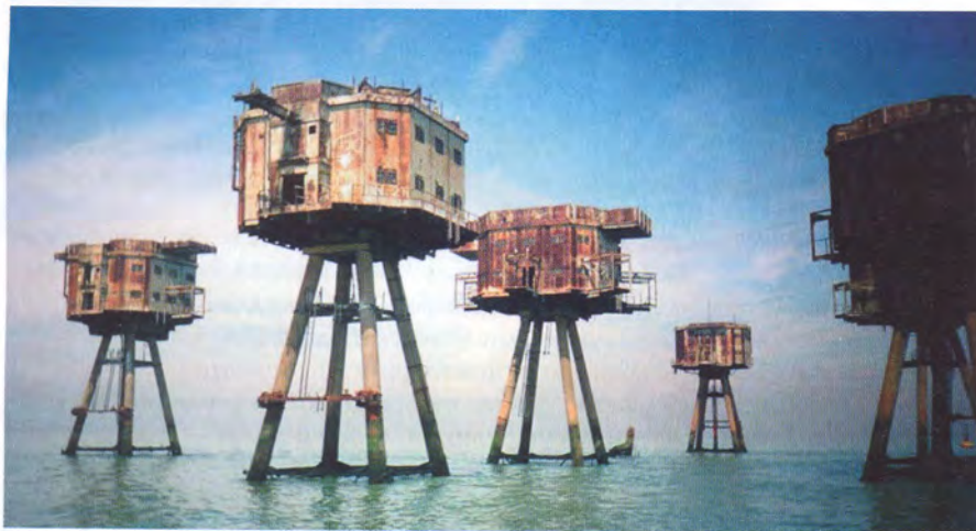
Современное состояние фортов Маунселла. Переходные мостики демонтированы, из воды торчат обломки конструкций
