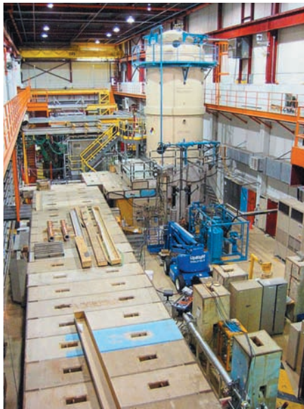
Установка электронного охлаждения на 5 МВ в лаборатории им. Ферми (США)
