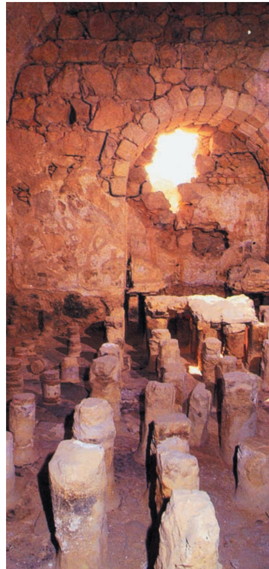
Колдариум (горячая комната) в бане, примыкающей к Северному дворцу. Более двухсот столбиков, которые видны на фото, служили основанием пола с подогревом
