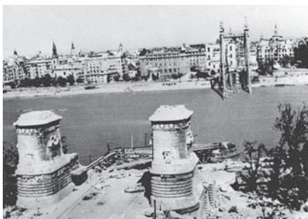
Один из Будапештских мостов через Дунай, подорванный немцами в ходе обороны города. Февраль 1945 г.
