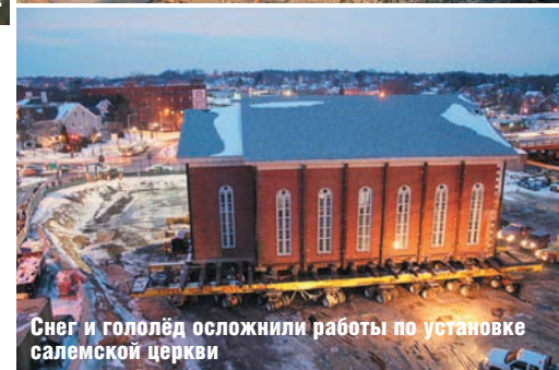
Чтобы снять салиемскую церковь с фундамента, не повреждая здание, пришлось вырыть глубокий котлован
