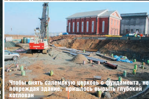
Дать разрушиться одной из первых церквей в Массачусетсе было бы преступлением. Перенос на новый фундамент позволил спасти памятник архитектуры
