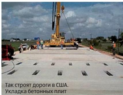
Так строят дороги в США. Укладка бетонных плит
