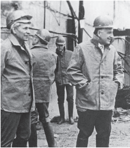
Б.М. Понтекорво, С.С. Герштейн (слева) на строительстве Баксанской нейтринной лаборатории. 1974 г.
