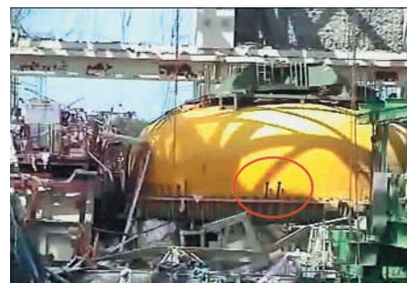
Фото верхней части реактора 4-го энергоблока, снятого с БЛА T-Hawk через проём в разрушенной стене здания. Жёлтый купол — стальная защитная оболочка реактора. Снято с БЛА T-Hawk 15.04.11
