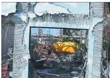
Фото верхней части реактора 4-го энергоблока, снятого с БЛА T-Hawk через проём в разрушенной стене здания. Жёлтый купол — стальная защитная оболочка реактора. Снято с БЛА T-Hawk 15.04.11
