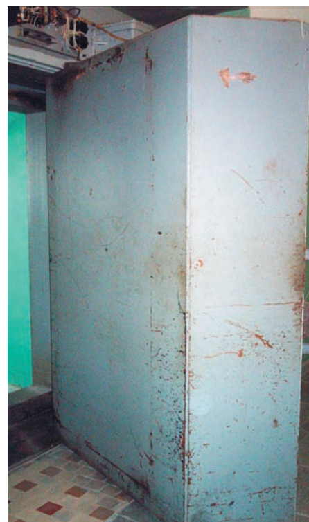
За этой дверью, что ведёт в помещение с радиационной защитой, тестируют каждый собранный прибор. Толщина двери – 0,5 м – демонстрирует степень защиты
