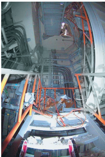
Робот Quince внутри реакторного блока №3. Узкая лестница со 2-го на 3-й этаж, по которой поднимался робот
