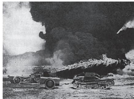
**Итальянская огнеметная танкетка CV3 L.F на маневрах. Боевая масса — 3,3 т. Экипаж — 2 чел. Вооружение — один огнемет. Толщина брони: лоб корпуса — 13 мм, борт — 8 мм. Двигатель — «Фиат», 40 л.с. Скорость по шоссе — 42 км/ч. Запас хода по шоссе — 150 км.**
