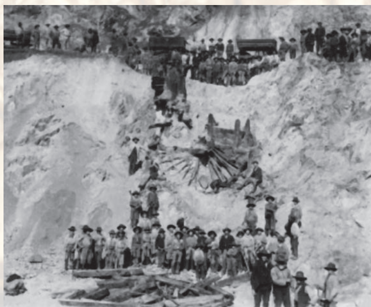
Рис. 7. Обнаруженные при разработке борта карьера Рио Тинто водоотливные колёса римского времени (фото второй половины XIX в.). Исторический архив музея Рио Тинто
