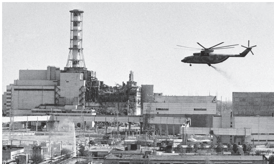
Разрушенный взрывом четвёртый энергоблок ЧАЭС спустя несколько дней после аварии
