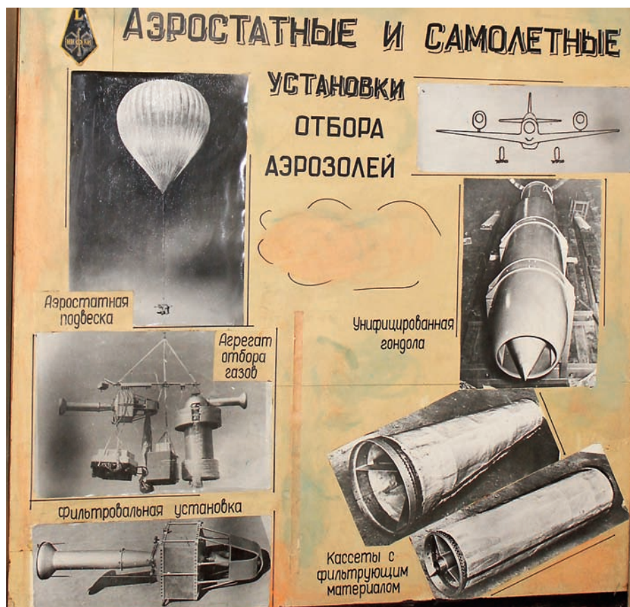
Аэростатные и самолётные установки для сбора аэрозолей
