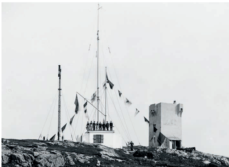
она примерно в том состоянии, в котором была во время, когда Тесла зафиксировал «слишком телеграфа Маркони. Надо полагать, что в сооружении под антенной находится таинственный «ящик»
