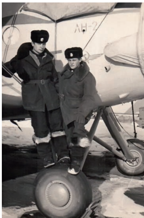
На самолёте Ан-2 шасси неубирающееся, что позволяет ему взлетать на колёсах при глубине снежного покрова 25–35 см (высота унта). Обычно зимой вместо колёс устанавливались лыжи. Гидросамолёт Ан-2В «стоял» на поплавках. За хорошую проходимость Ан-2 в шутку называли «трактором». (На снимке справа — автор статьи)
