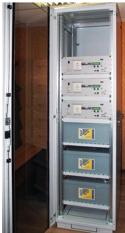
**Для размещения трёхфазной системы в стандартной 19-дюймовой стойке выпускаются инверторы в соответствующем конструктивном исполнении. Аналогичную систему можно собрать и просто на стеллаже из приборов в обычных корпусах**
