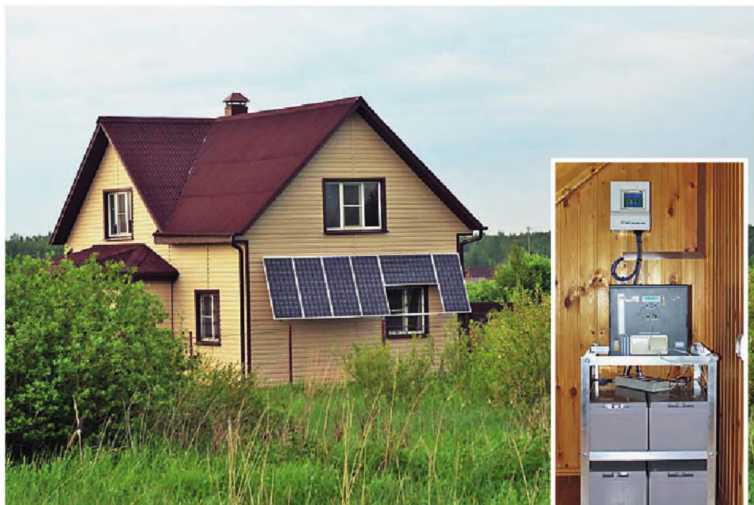
Вот такой домик недалеко от Клина. Вся система управления вместе с аккумуляторами (на врезке) помещается под лестницей: на стене — контроллер СП, на стойке вверху — инвертор MAP SYN Энергия, внизу — АКБ
