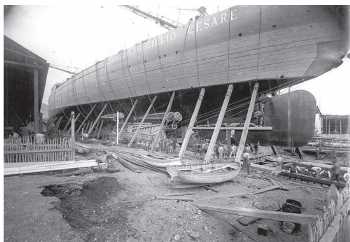
Постройка корабля. Видно, что винтов пока ещё четыре
