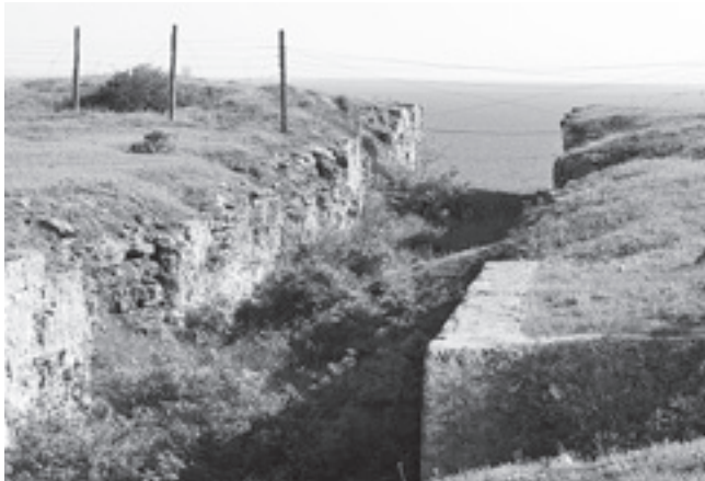
Оборонительные рвы 19-й батареи
