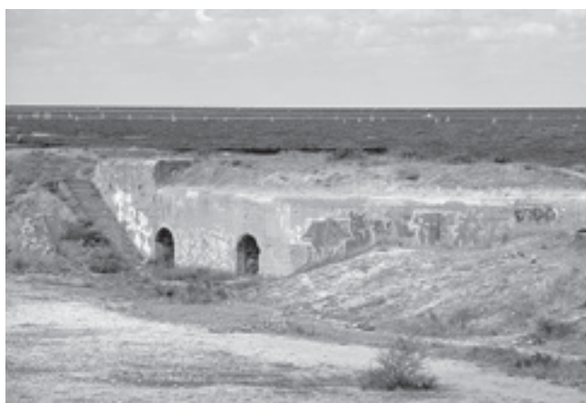
Бетонный массив с погребями 23-й батареи
