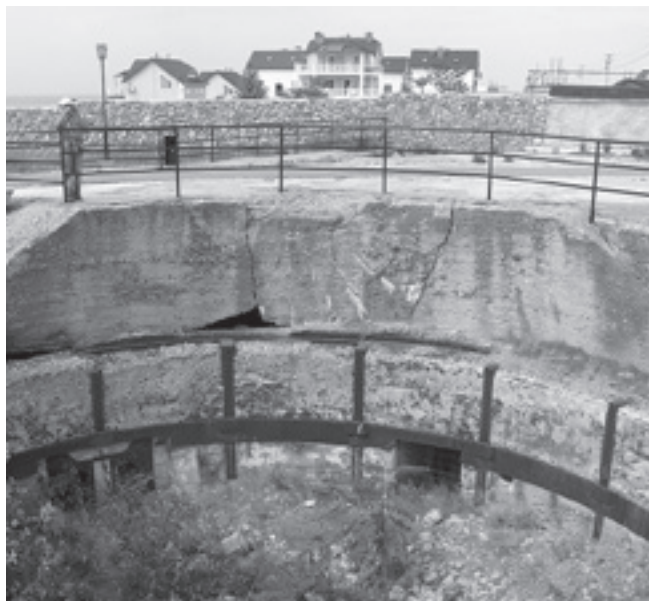
Установочные части 305-мм батареи № 35. Видны дома, построенные буквально на костях десятков тысяч человек
