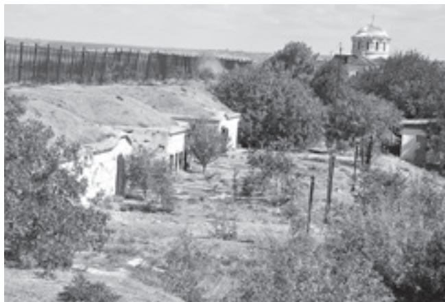
Казематы мортирной батареи № 12
