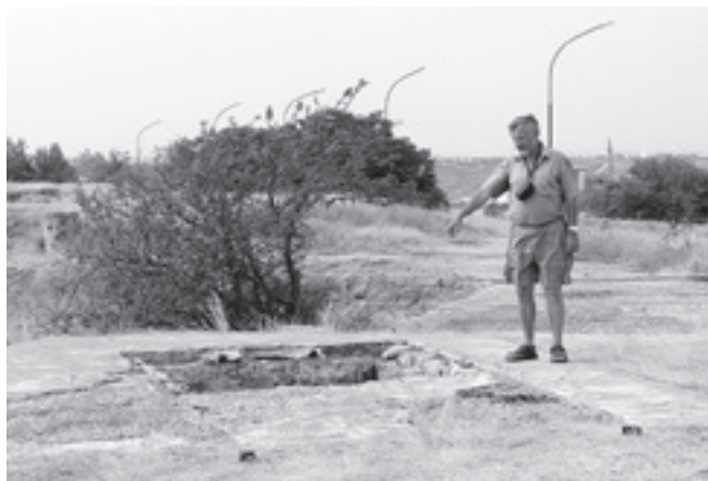
Автор на 16-й батарее показывает колодец для скрывающегося прожектора
