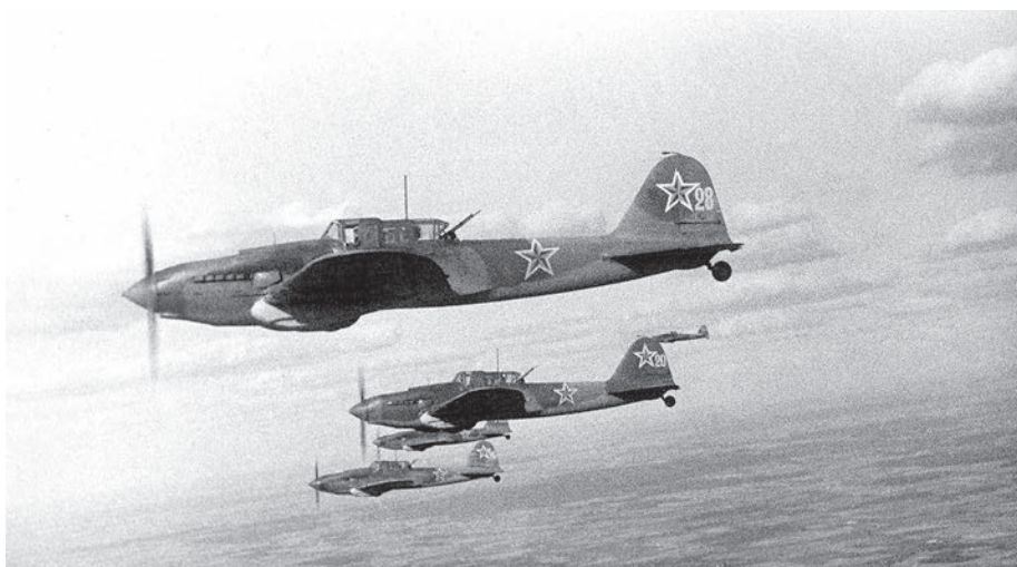
На Ил-2 ШКАСы были оставлены только для стрельбы вперёд по пехоте. Оборонительным был изначально УБТ
