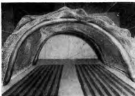
Внутренний вид зерносклада с пневматическими арками.
