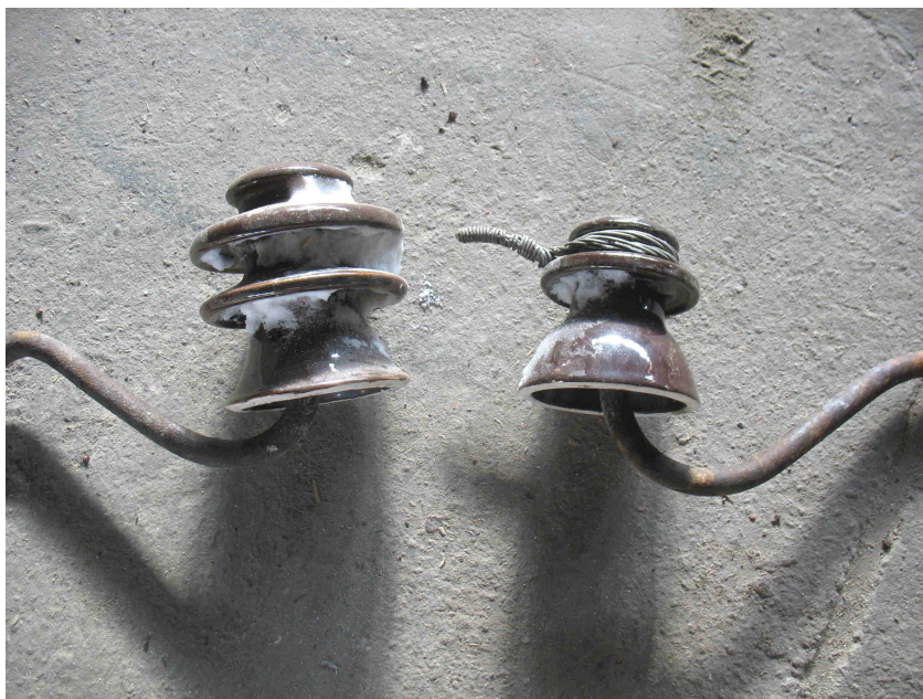
Рисунок 6.4 Фарфоровые изоляторы линий электропередач. Между фарфоровым изолятором и стальным крюком втулка из полиэтилена, для защиты фарфора от трещин. Дисковая форма изоляторов позволяет воде стекать не образуя сплошного слоя, замыкающего проводник на опору. Фарфоровые изоляторы, в отличие от стеклянных, непрозрачны, что затрудняет визуальную проверку изолятора на наличие трещин.
