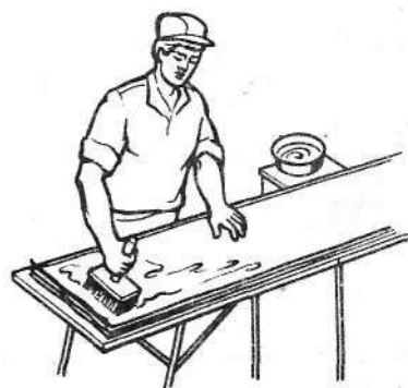
Рис. 231. Нанесение клея на обои
