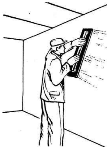
Рис. 210. Выравнивание, затирка оштукатуренной поверхности
