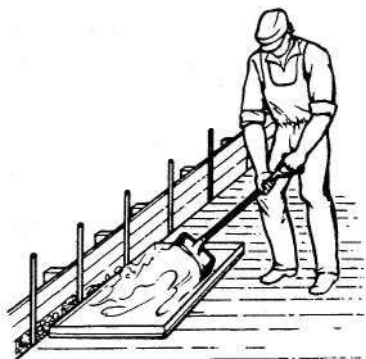
Рис. 74. Использование настила при бетонировании стены
