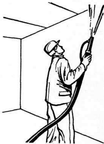
Рис. 213. Механическое нанесение грунтовки на поверхность потолка
