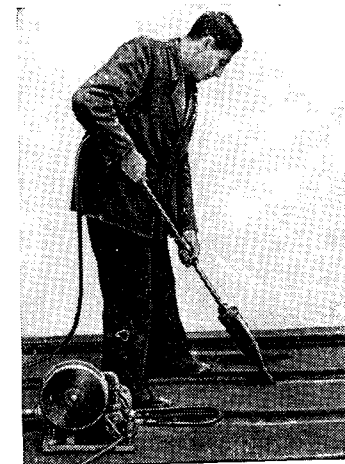
Фиг. 56. Сварка держателем ДШ-14.
