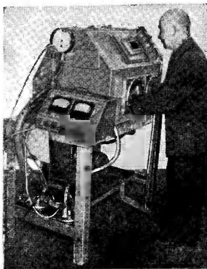
Фиг. 172. Камера с контролируемой атмосферой для ручной сварки.
