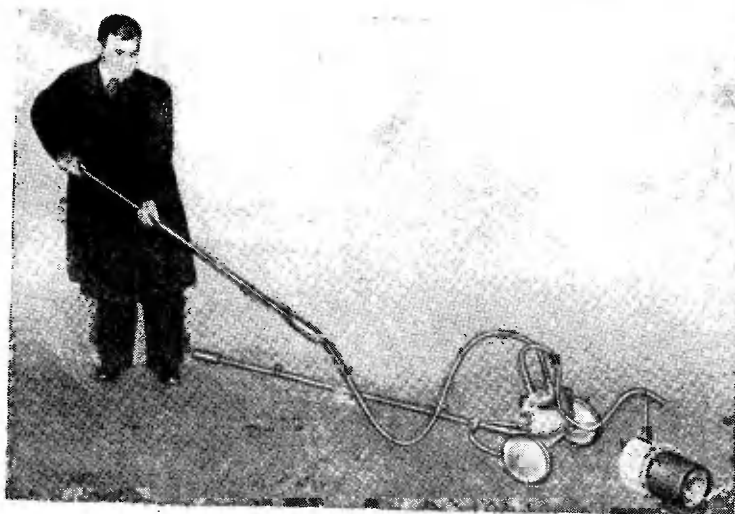
Фиг. 8. Передвижная гамма-установка МВТУ для контроля сварных стыков труб
