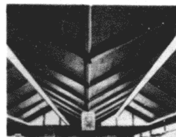
Стальная стойка опоры
