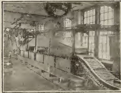
AF APRON WASH-TANK CONVEYOR
