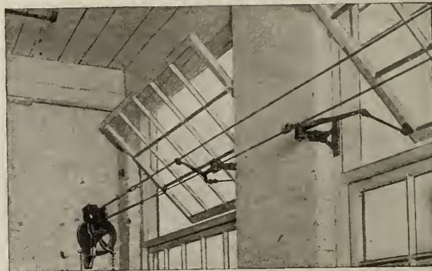
FIG. 3. TENSION LEVER APPARATUS
